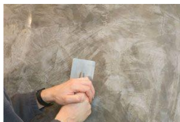
La surface savonnée est ferrée sous pression.
