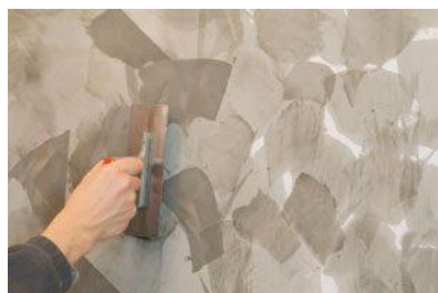
Troisième étape, les derniers espaces restants sont couverts.
