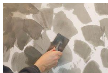
Après l'application des premiers patches, des patches supplémentaires sont appliqués entre les deux.
