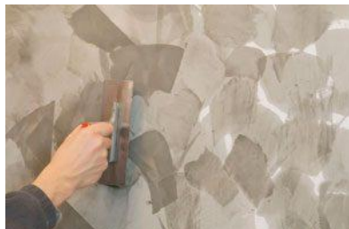
Application de la deuxième couche.
