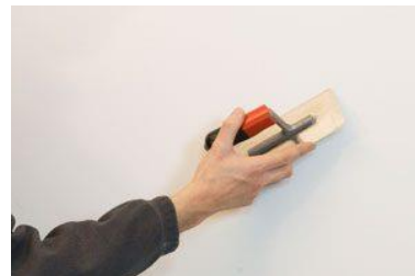
Les légères bavures de la finition murale à la chaux 0,5 mm sont grattées à l'aide de la truelle.
