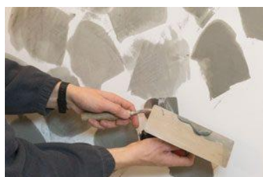
Ne travaillez qu'avec une petite quantité de matière sur la truelle.
