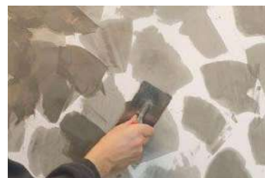
Après l'application des premiers patches, des patches supplémentaires sont appliqués entre les deux.
