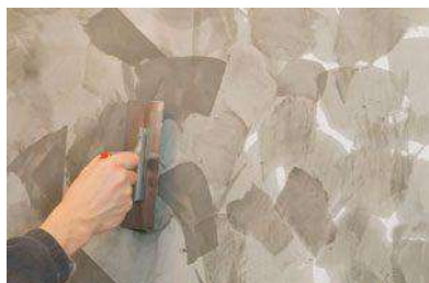
Application de la deuxième couche.
