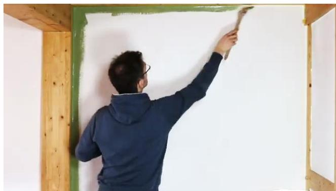
***ASTUCE*** : *Il y a une petite zone de superposition entre le découpage au pinceau et l'application au rouleau. Si on crée une épaisseur cela pourrait se voir (texture et/ou teinte). Étirer la peinture de l'intérieur de l'angle vers l'extérieur sans faire une découpe trop large.*
